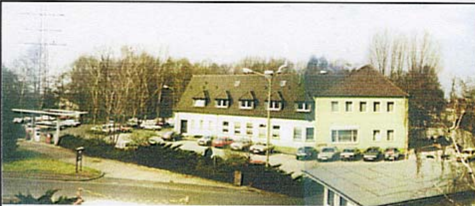
Kantinegebäude (Südseite) und Parkplatz mit Tankstelle
