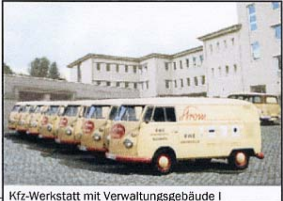
Kfz-Werkstatt mit Verwaltungsgebäude I
