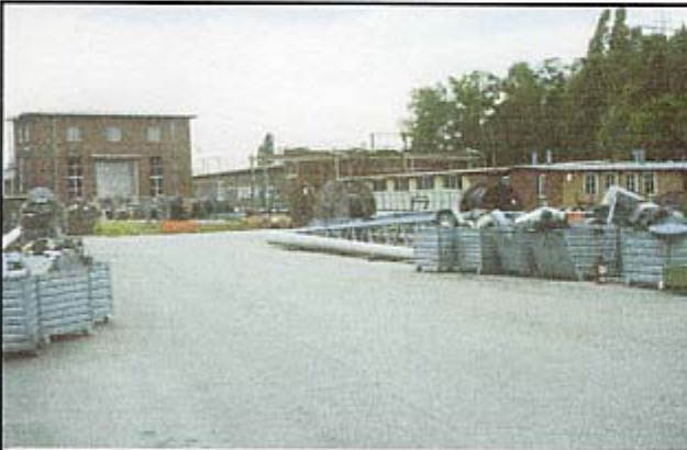
Lager- und Werkstattgebäude
